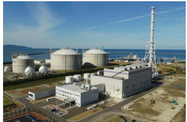
新潟県上越市 上越火力発電所 (写真提供:東北電力)
